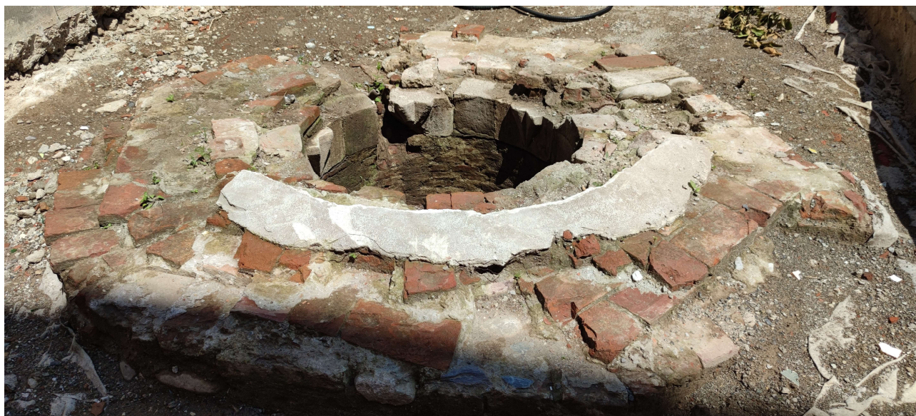
Figura 3 foto generale del pozzo_ visibile il dettaglio della ghiera in marmo alternato a pietra nera con le mensole in aggetto.
