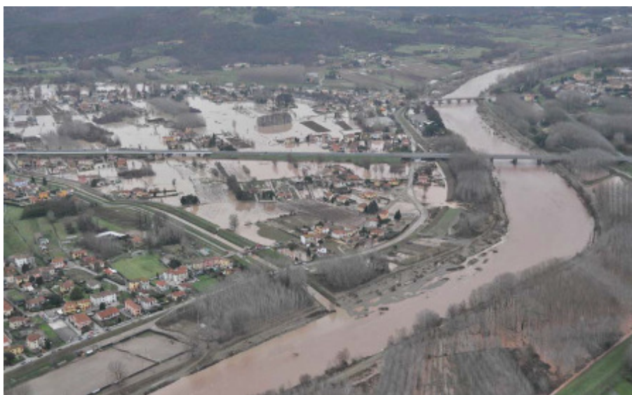
Vista aerea della zona di Ponte San Pietro a seguito dell'evento di piena del 25 dicembre 2009
