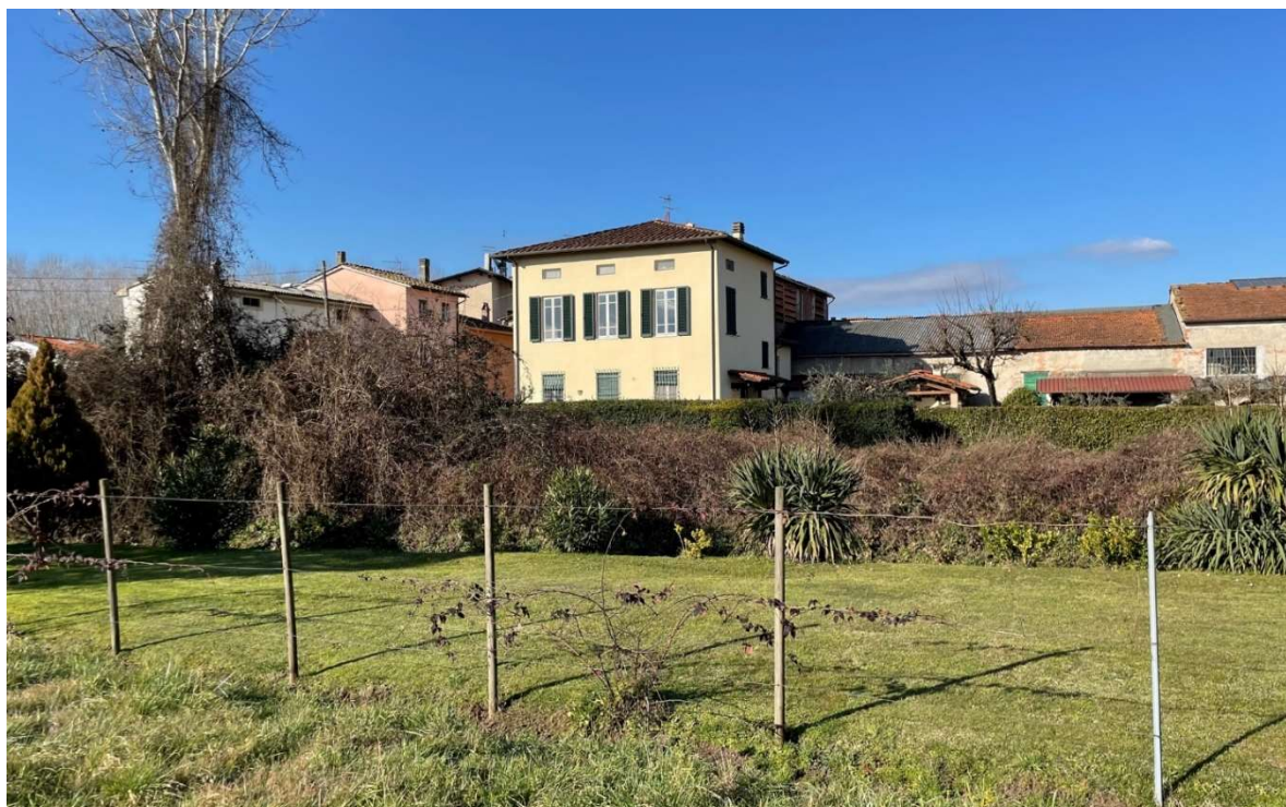
Figura 3.8: Edificio B su Via dei Pellegrini
