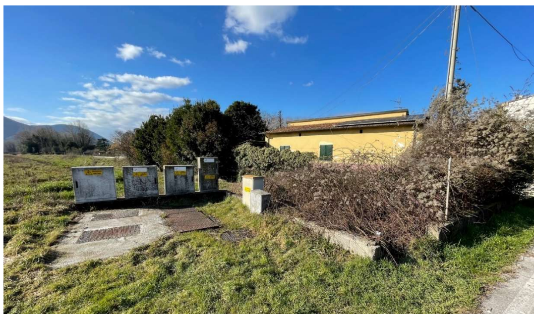
Figura 3.11: Edificio C su Via dei Pellegrini
