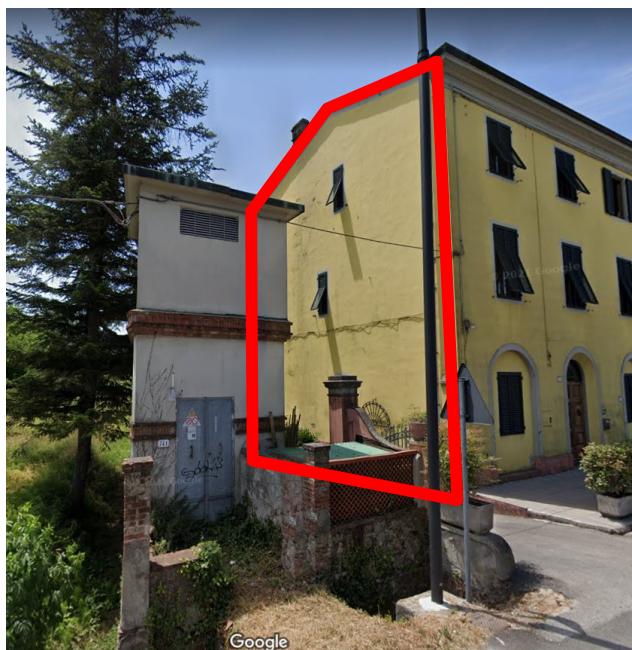
Figura 4.26: Facciata edificio A, ricettore R11 (fonte google maps)
