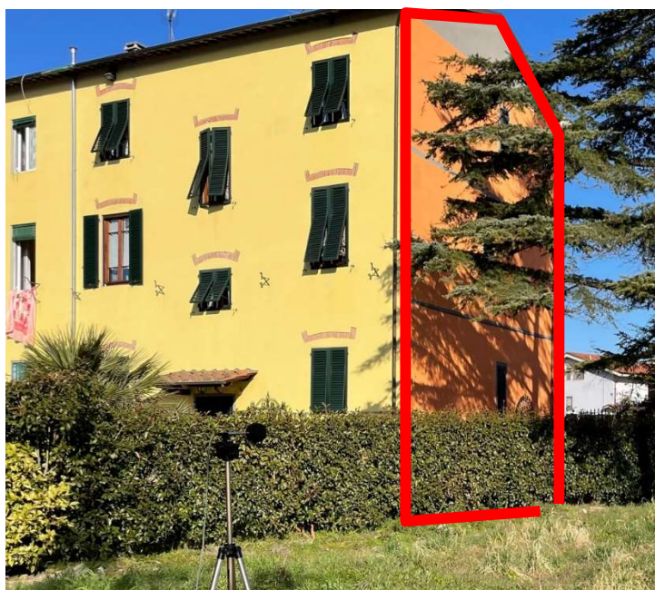
Figura 4.25: Facciata edificio A, ricettore R11 (foto 28/01/2022)
