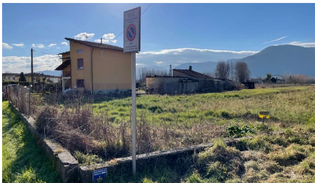
Figura 3.13: Edificio D su Via dei Pellegrini
