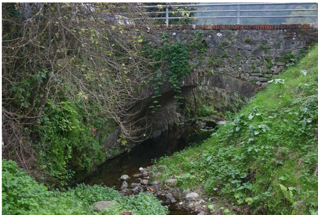
Figura 3.7 – Attraversamento ad arco sulla via comunale per Torre
