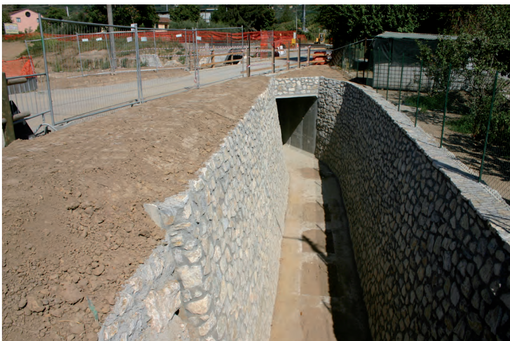
Figura 3.3 – Lavorazioni durante la messa in sicurezza del corso d'acqua nella parte bassa
